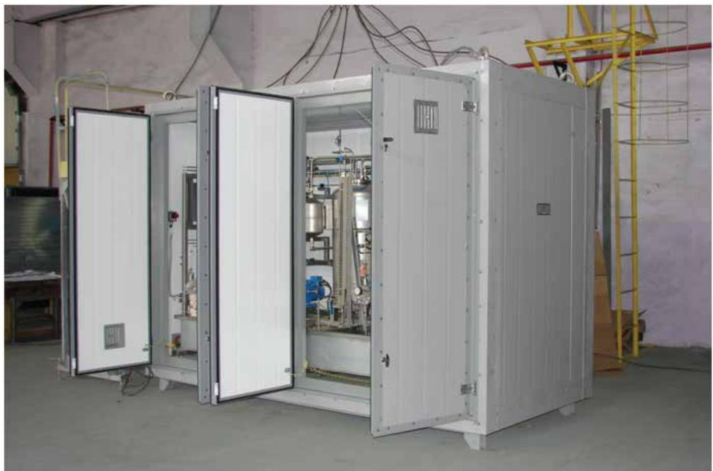
Установки одоризации зарекомендовали себя как простое и надежное оборудование, применение которого все активнее распространяется и на новые сегменты рынка, такие как одоризация сжиженных газов LPG и CNG, а также при подаче природного сжиженного газа в распределительную газотранспортную сеть.
